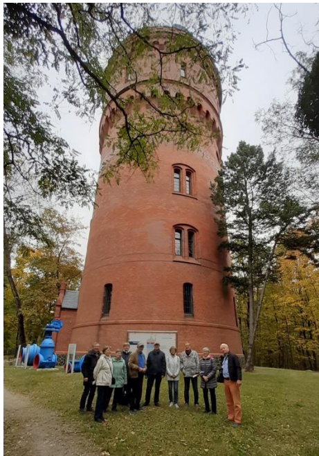
Der Wasserturm mit 198 Stufen bis zur Plattform
