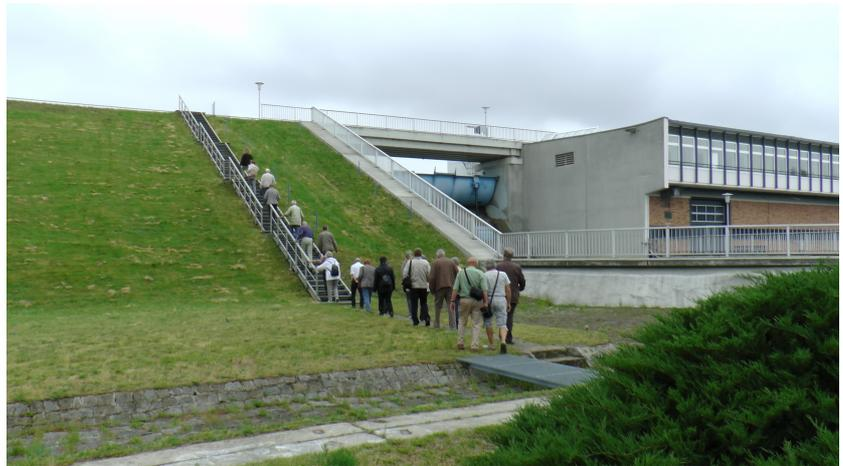
Das Sperrwerk ist von 1958 bis 1965 erbaut worden. Die Planungsarbeiten begannen schon lange vorher. Es war eine Herausforderung, in dem lockeren Schwemmsandboden ein solches Sperrwerk zu errichten. Nicht nur die Sperrmauer, auch der Stausee befindet sich auf wasserdurchlässigem Sand. Im Gegensatz zu Talsperren im Gebirge gab es für eine solche Flachlandtalsperre keine Erfahrungen. Es wurden deshalb zunächst Erprobungsbauten errichtet.
