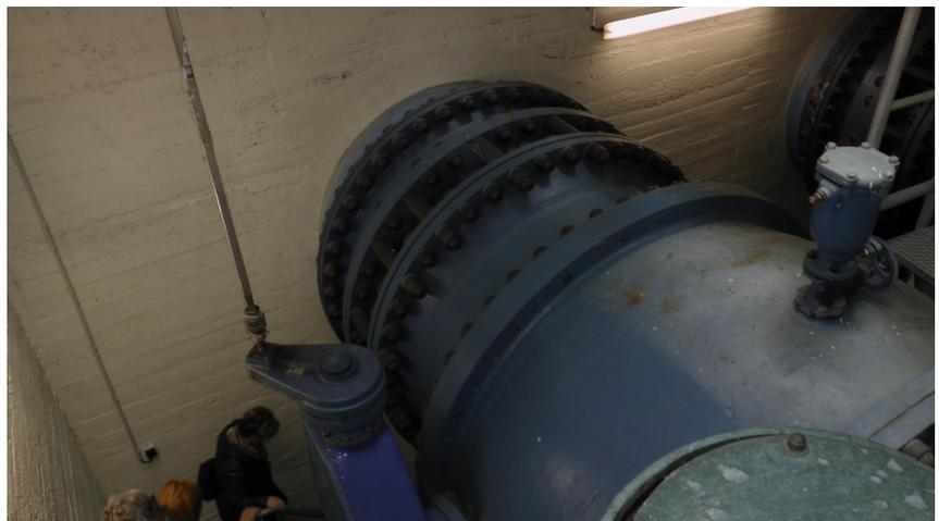
Errichtung des Bauwerkes eingebaut wurden. Die Schieber der Grundablässe werden heute per Computer über eine hydraulische Anlage betätigt. Das funktioniert aber nur, wenn elektrischer
