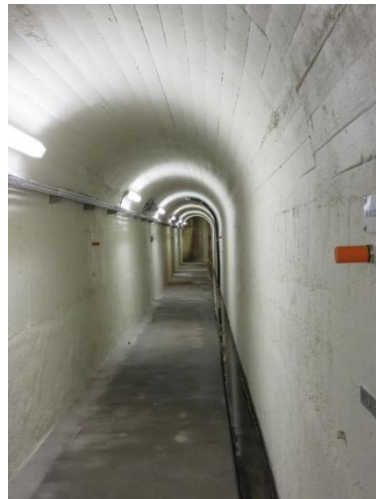
Kontrollgang im untersten Teil des Sperrwerkes
