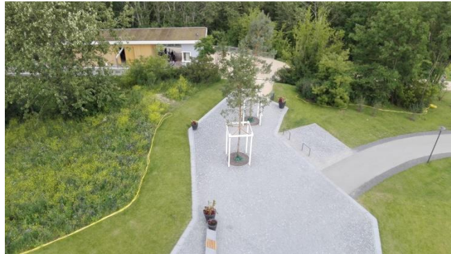
Sicht vom Wolkenhain mit Blick auf die Bobbahn
