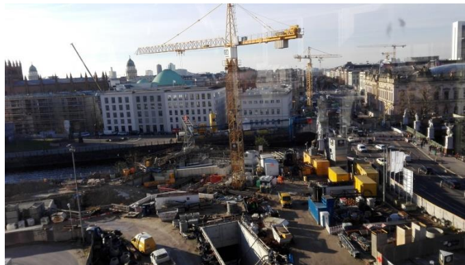
Baustelle von oben
